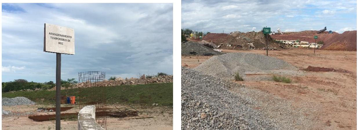
Figura 19 - Área de disposição de RCC no Aterro Sanitário. Fonte: SERENCO.
